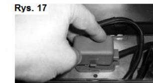
Założyć i zapisać skrzynki połączeń
